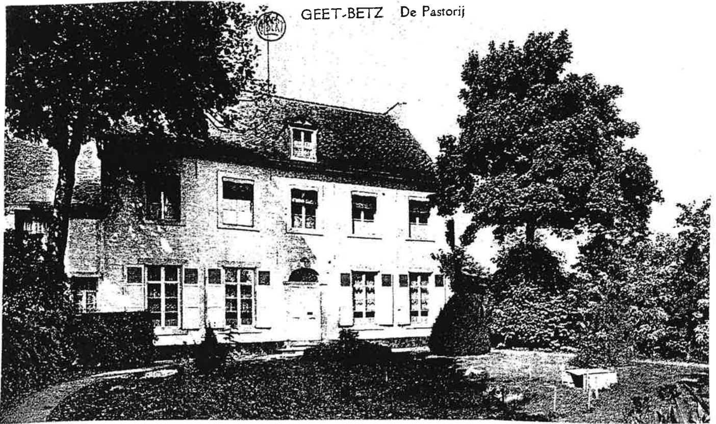
Afb. 8. Zicht op de voorgevel van de pastorij van Geetbets (1923).
